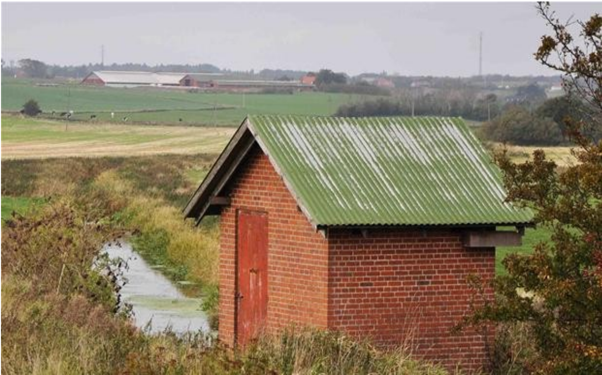
Hundsø på Mors. Et typisk stykke af vandet Danmark med tilhørende pumpehus. Foto: Helge Røjle © DR
